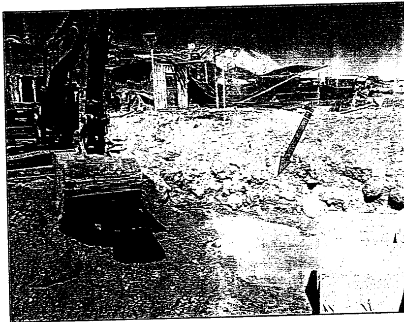
Foto N° 05: Vista del enrocado luego de retirar las rocas que invadían la zona para poder cimentar la zapata Z14 del área de Desinfección.
