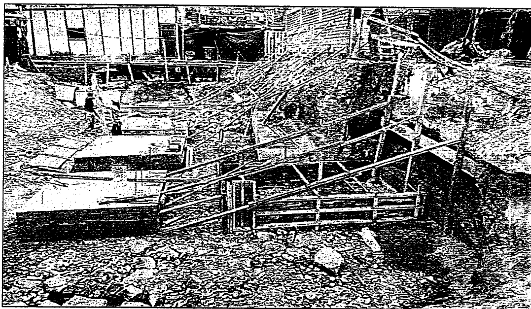
Foto N° 04: Vista de la ejecución de falsas zapatas cimentadas sobre el suelo mejorado.
